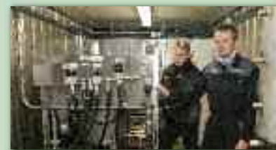
Servicekonsulenter installerte ny kraftsentral hos Södra Cell Tofte.
