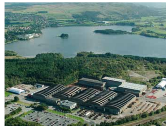
Plogfabrikken på Klepp ruver i landskapet
